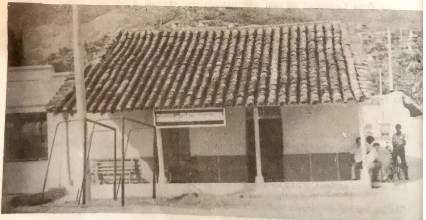
CASA PARTICULAR, DONDE ESTABA EL CORREO. ACTUALMENTE HAY UNA VENTA DE APARATOS ELECTRICOS.
