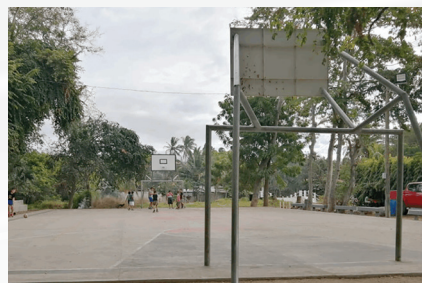
CONSTRUCCIÓN CANCHA POLIDEPORTIVA BARRIO EL RETIRO, ALDEA EL ROSARIO, RÍO HONDO, ZACAPA. Q.200,000.00
