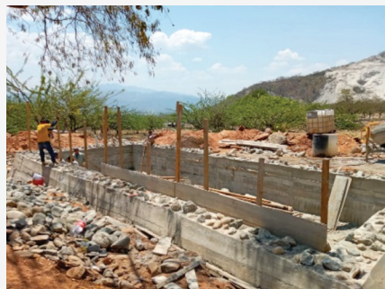
CONSTRUCCIÓN TANQUE DE MAMPOSTERIA ALDEA NUEVO SUNZAPOTE, RÍO HONDO, ZACAPA. Q.300,000.00
